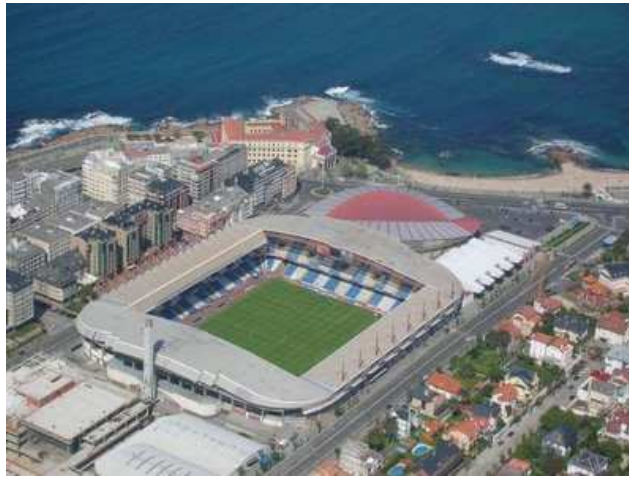
Imagen 14. Vista del Estadio de Riazor (A Coruña)
